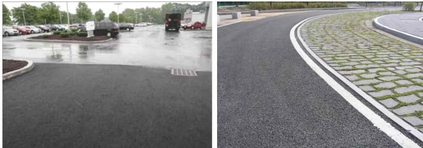
[그림 3-7] 투수성포장의 시공 사례
