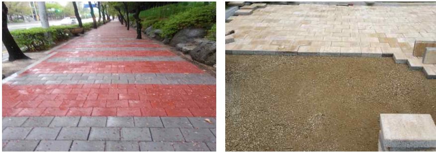
[그림 3-6] 투수블록의 시공 사례
