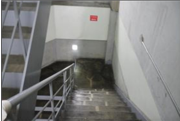
모니터링 장소 : 비상구 계단 사진 설명 : 수유실로 내려가는 계단임.
