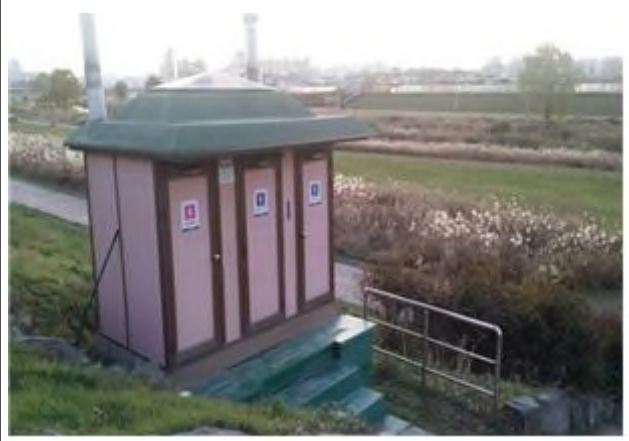
중촌동 진입로 계단 옆 자연발효위생화장실 하천 진입 계단 옆에 위치해 있어 유모차나 장애인의 휠체어 접근이 불가능.
