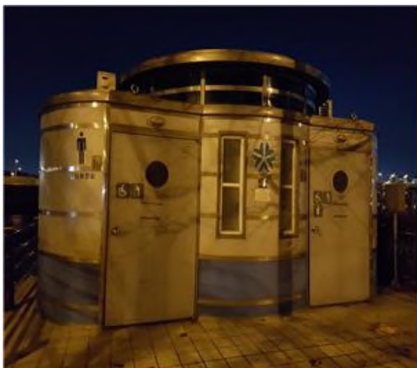
↑갑천 좌안 화장실 야간(불 꺼진 상태)
