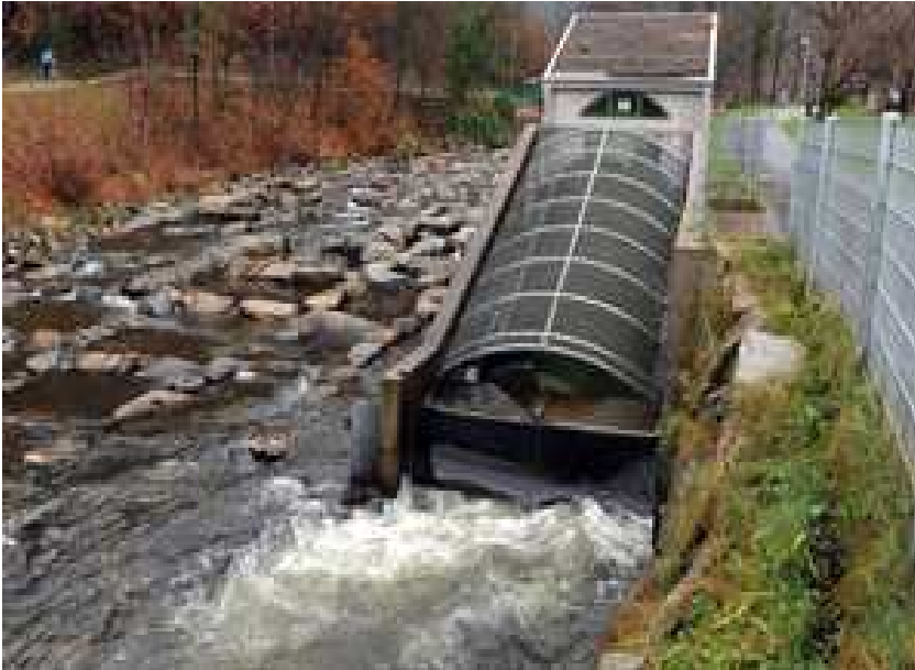
[그림 2-8] 베히레와 드라이잠 합류지점에 설치된 소수력 발전기
