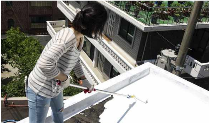
위) 옥상 흰빛 캠페인 시공 사례, 아래) 페인트를 제공받아 스스로 시공하는 사례 자료: 경향신문 <기사자료>(2014), ( http://bomida.khan.kr/267 ) 데이터 뉴스 <기사자료>(2015), ( http://m.datanews.co.kr/m/m_article.html?no=79203 )
