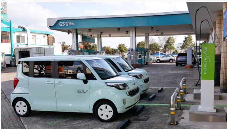
[그림 4-12] 주유소에 전기차 충전기를 설치한 사례
