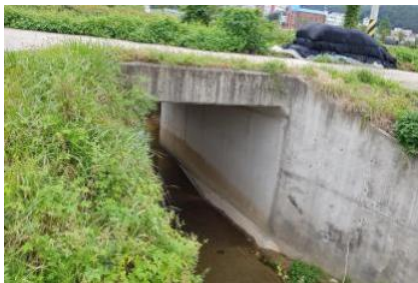
하류의 교량 및 제방
