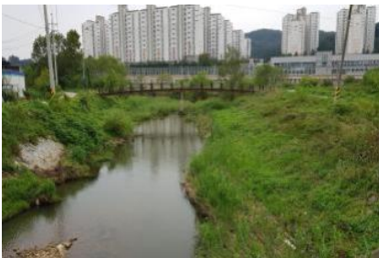
하류의 교량 및 하상(탁한 수질)
