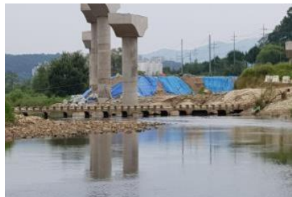
하류의 교량 공사
