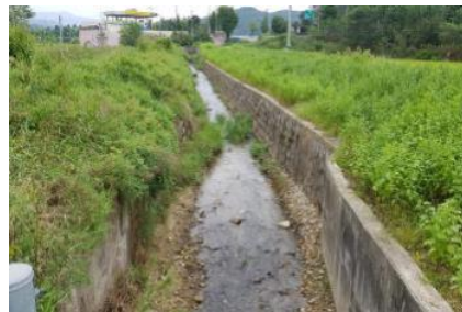
최하류의 콘크리트 제방
