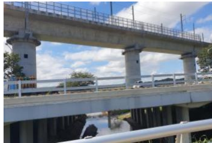
하류의 교량에 의한 비점유출 가능성
