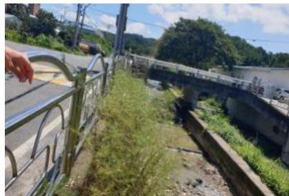
중류의 도로 옆 하천
