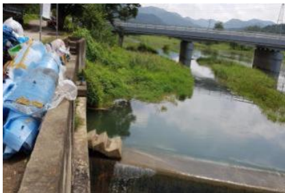
하류의 교량 및 쓰레기
