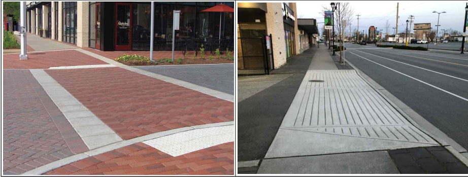
[그림 3-9] 보도 차량진출입구간의 조성 사례
