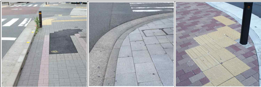
[그림 3-12] 보도면을 연석보다 낮게 설치한 사례(일본 도쿄)
