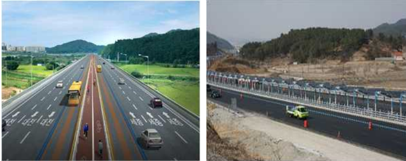
<그림 15> 세종시에 건설중인 중앙분리대 형식의 첨단 자전거도로
