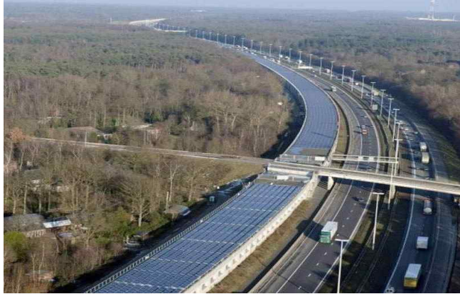
<그림 9> 벨기에의 터널에 설치된 태양광 터널
