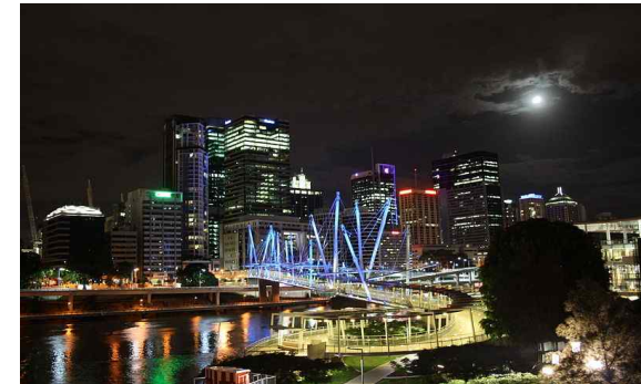
<그림 8> Kurilpa 교량에 설치된 태양광 시설
