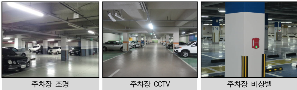
[그림 4-20] 주차장 조명·CCTV·비상벨 설치
