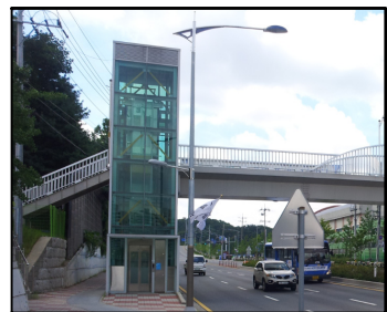
입체횡단시설 E/V 설치
