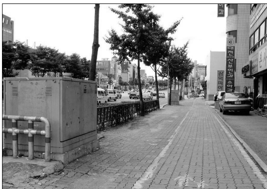
〈그림 2-12〉 승차감이 낮은 재질로 시공한 자전거도로
