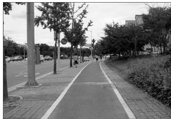
〈그림 2-12〉 승차감이 낮은 재질로 시공한 자전거도로
