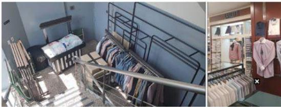
▲ 24일 수원시 권선구 권선동에 있는 NC백화점 비상구 계단이 의류 매대와 물품 박스 등으로 가려져 비상 신속한 대피가 어려워 보이는 모습(왼쪽). 또 팔달구 인계동 2001아울렛의 한 의류매장에는 방화셔터가 내야할 공간에 의류대가 설치돼 있고 벽면에 와이셔츠가 진열돼 있다. 유명동기자
