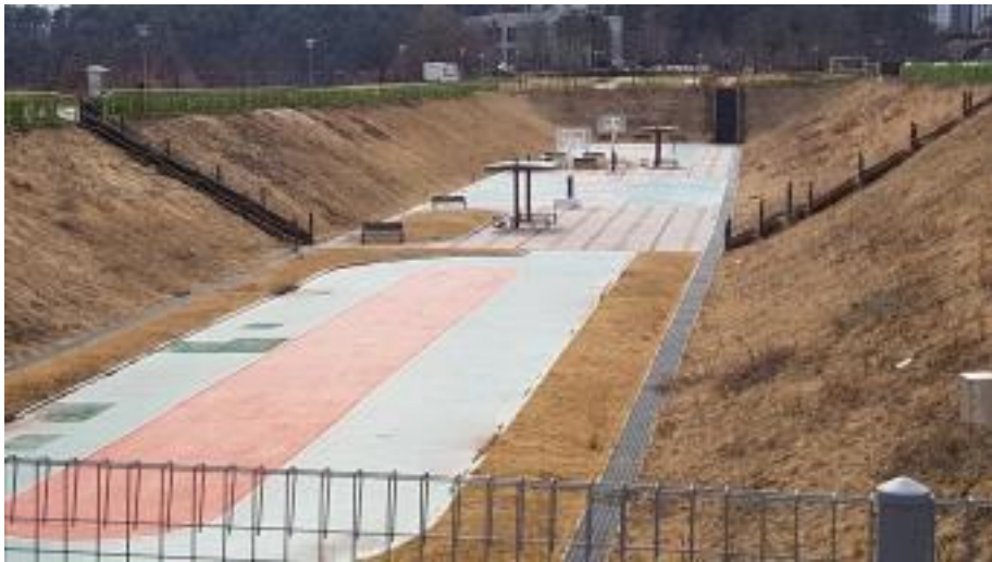
[그림 3-6] 우수저류지 2-6 현장 사진
