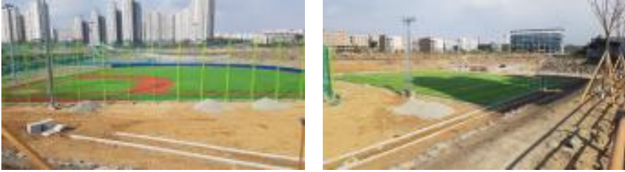
[그림 3-4] 우수저류지 2-1 현장 사진
