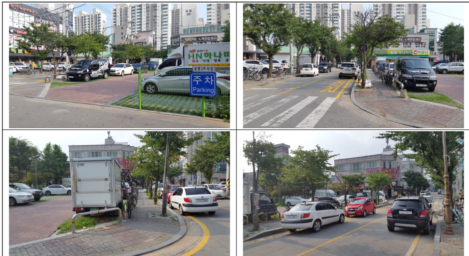
[그림 2-5] 조치원 침산리 공영3주차장 현장
