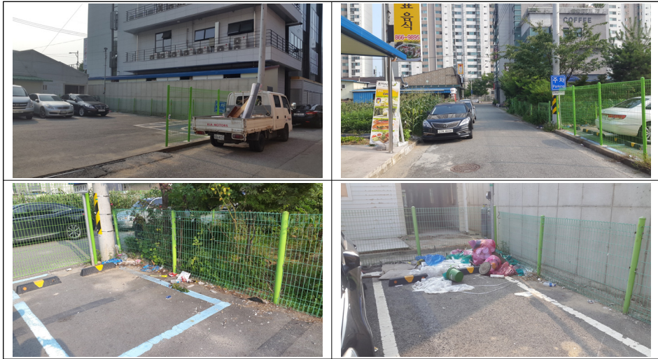
[그림 2-6] 조치원 침산리 공영4주차장 현장
