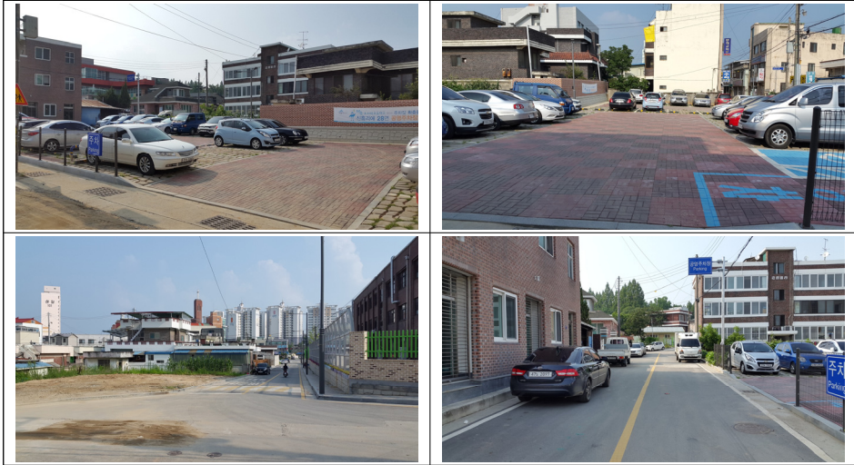
[그림 2-10] 조치원 신흥리 공영주차장 현장
