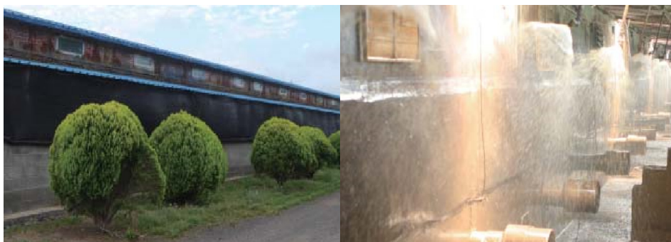
〈악취저감시설 바이오커튼 설치〉
