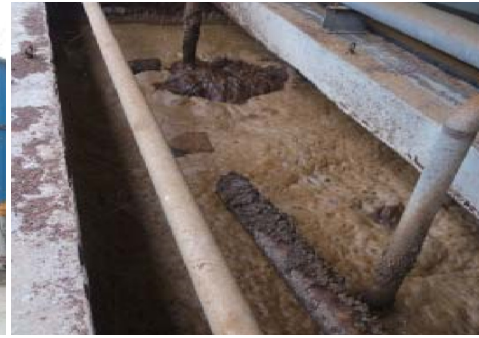
〈축사 내 설치된 액비순환시스템〉
