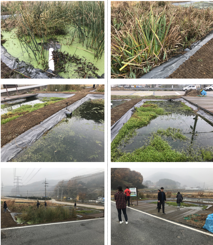
[그림 3-6] 비선마을 자연형 저감시설의 구조 (상좌:1번습지, 상우:2번습지, 중좌:3번습지, 중우:4번습지, 하좌:저감시설 전경, 하우:주기적인 관리)
