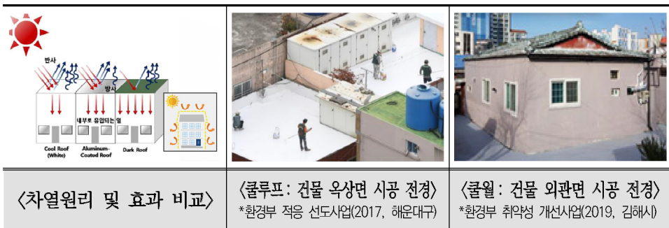
〈그림 3-16〉 차열사업 원리 및 시공전경 사례
