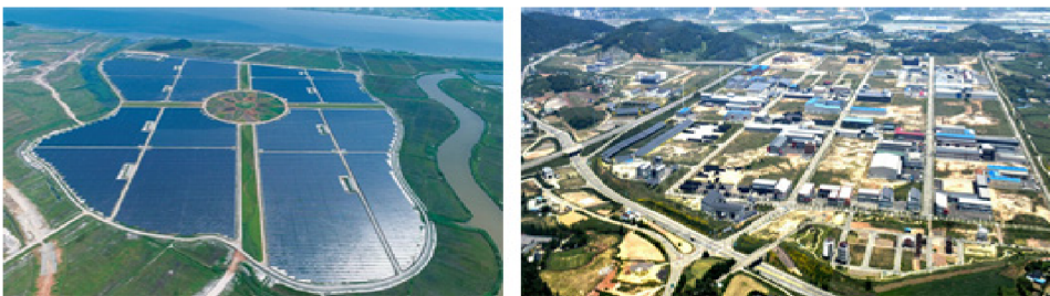
[그림 2-17] 전남 태양광 단지, 수소연료전지 발전소
