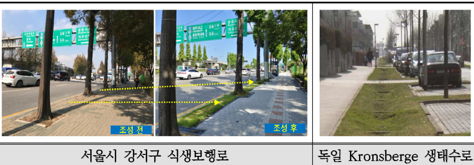
[그림 3-23] 국내외 보행로 공간 식생수로 및 녹지대(저류시설) 조성 예시
