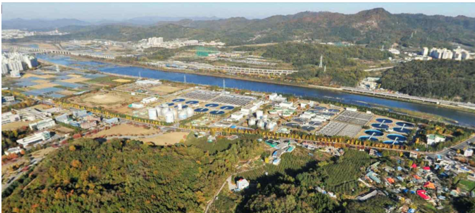
<그림 2-2> 대전하수처리장 전경
