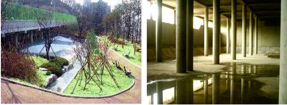
<그림 2-5> 빗물저류시설 상부 및 내부의 설치 현황
