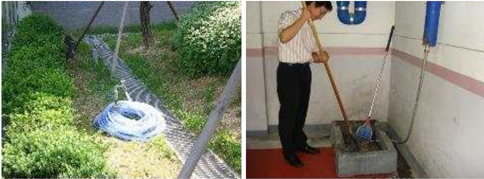
<그림 2-1> 빗물이용을 위한 수도전 및 청소용수 사용
