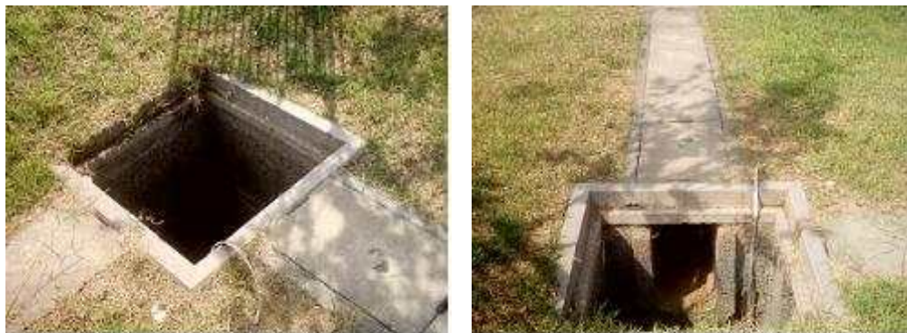
<그림 2-4> 빗물침투시설 중 침투통 및 침투측구
