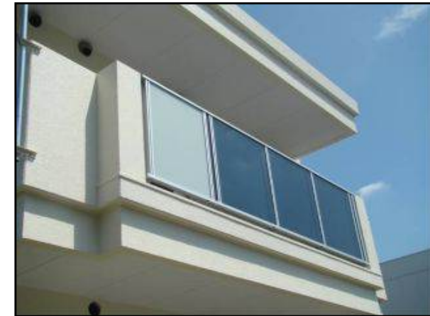
[그림 4-32] 단열공사가 필요한 장소(상)와 베란다에 설치한 태양열 시스템(하)
