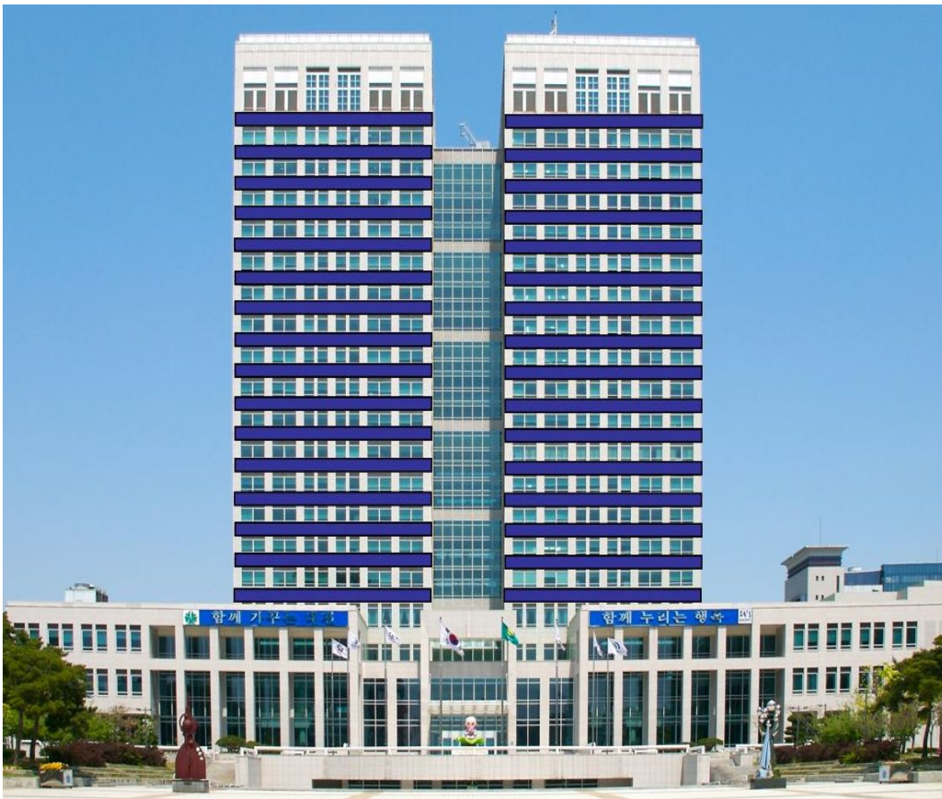
<그림 3-6> 대전시청 남측 벽면 중 태양광발전설비를 설치할 수 있는 면적
