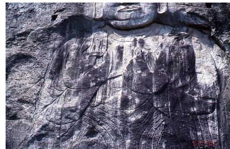
그림 22. 덕산 마애불. 석재의 풍화와 미생물로 인한 표면 오염 손상
