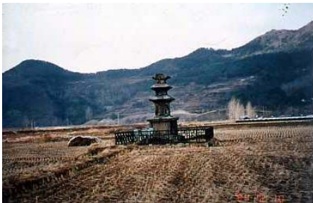
그림 21. 현일동 3층 석탑. 배수가 불량하여 이끼류 발생
