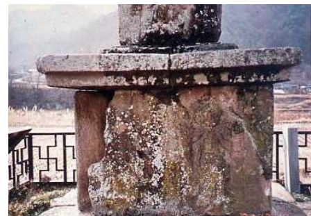
그림 24. 현일동 3층 석탑. 배수 불량으로 인해 지의류 자생
