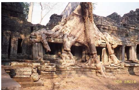
그림 23. 양골와트유적 거대 용수 뿌리로 인한 석조문화재 손상
