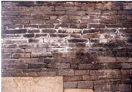
그림 19. 분황사 모전석탑. 표면 백화 현상
