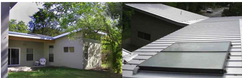
<그림 5-10> 미국, 오스틴에 설치된 친환경 건물의 모습
