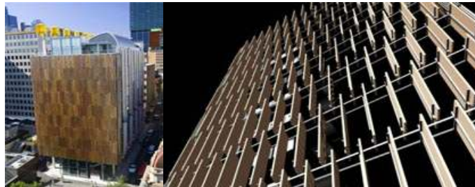
<그림 5-11> 오스트레일리아에 위치한 멜버른 의사당 빌딩
