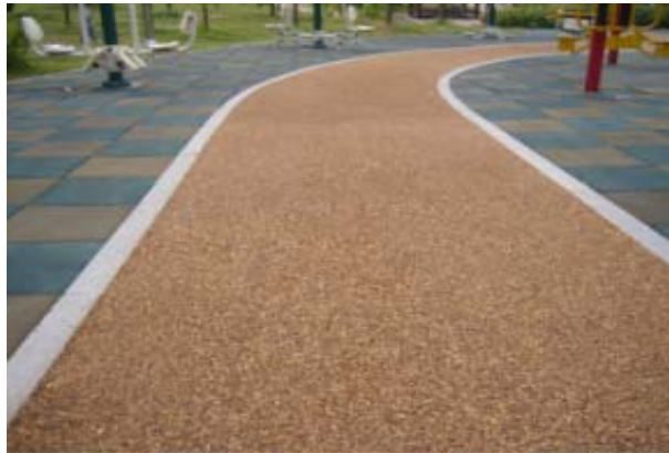
[그림 5-1] 공원 인도의 우드칩 시공 사례
