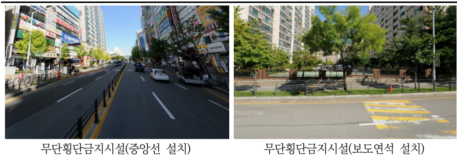
[그림 4-6] 무단횡단금지시설 설치 사례
