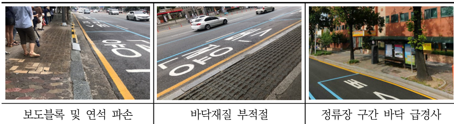
[그림 3-24] 정류장 바닥 설치현황
