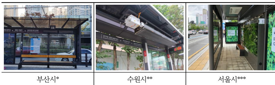
[그림 3-12] 정류장 난방시설 및 미세먼지 저감시설 설치사례
