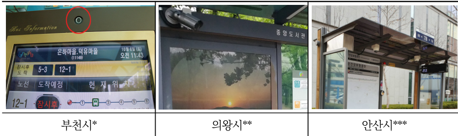
[그림 3-47] 정류장 CCTV 설치사례
