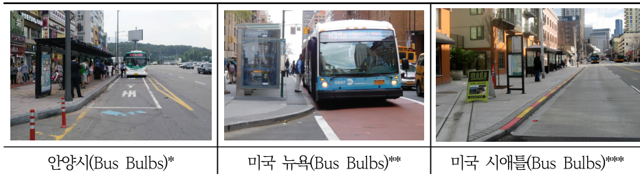
[그림 3-27] 돌출형 버스정류장(Bus-Bulbs) 설치사례
