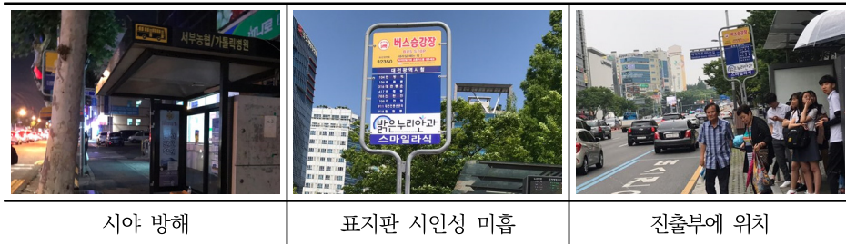
[그림 3-33] 정류장 표지판 설치현황
