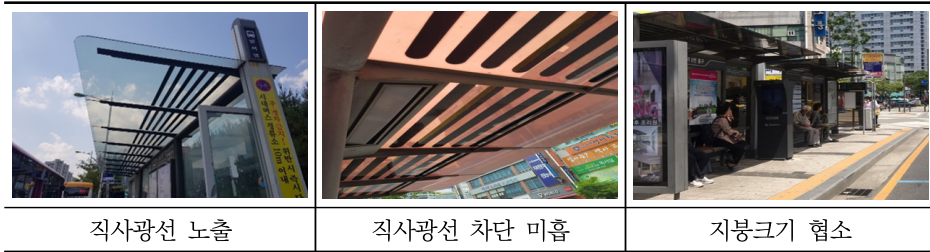
[그림 3-7] 정류장 쉼터 지붕 설치 사례
