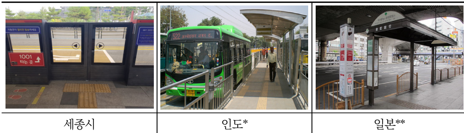
[그림 3-17] 정류장 스크린도어 및 펜스 설치사례
