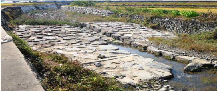
[그림 3-8] 소하천 시설물, 자연형 어도 시공사례
