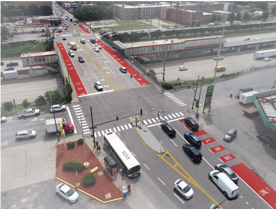
[그림 3-10] 시카고 79 th Street 버스전용차로
