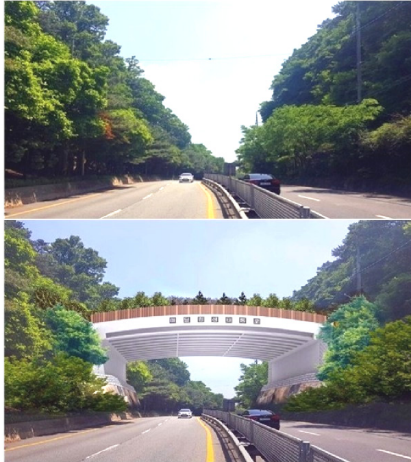
[그림 2-16] 마달령 생태통로 설치
