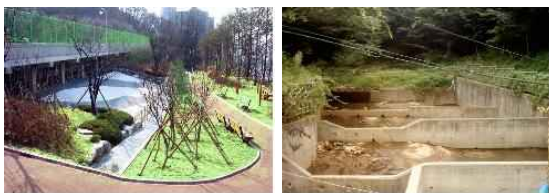
저류시설 상부(산책로) 저류시설 유입수로
