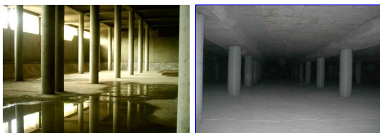
저류시설 내부(기둥, 바닥, 벽, 천정, 평상수로-측벽의 개거수로) 남산예정동 빗물저류시설 내부
