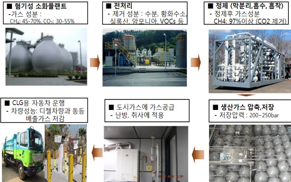
[그림 6-4] 음식물쓰레기 처리장내 메탄가스 정제 플랜트
