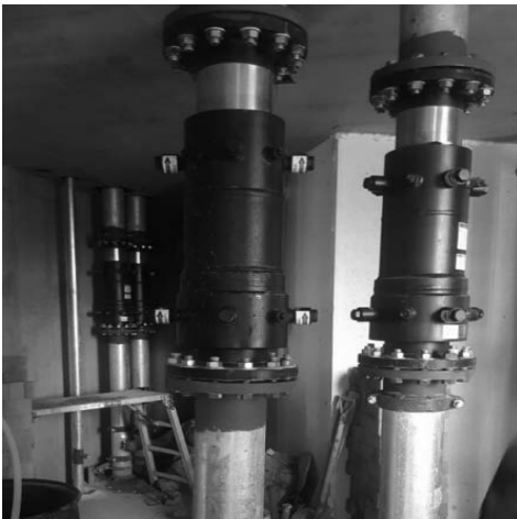
(c) 입상배관의 멀티조인트 활용 내진 시공
