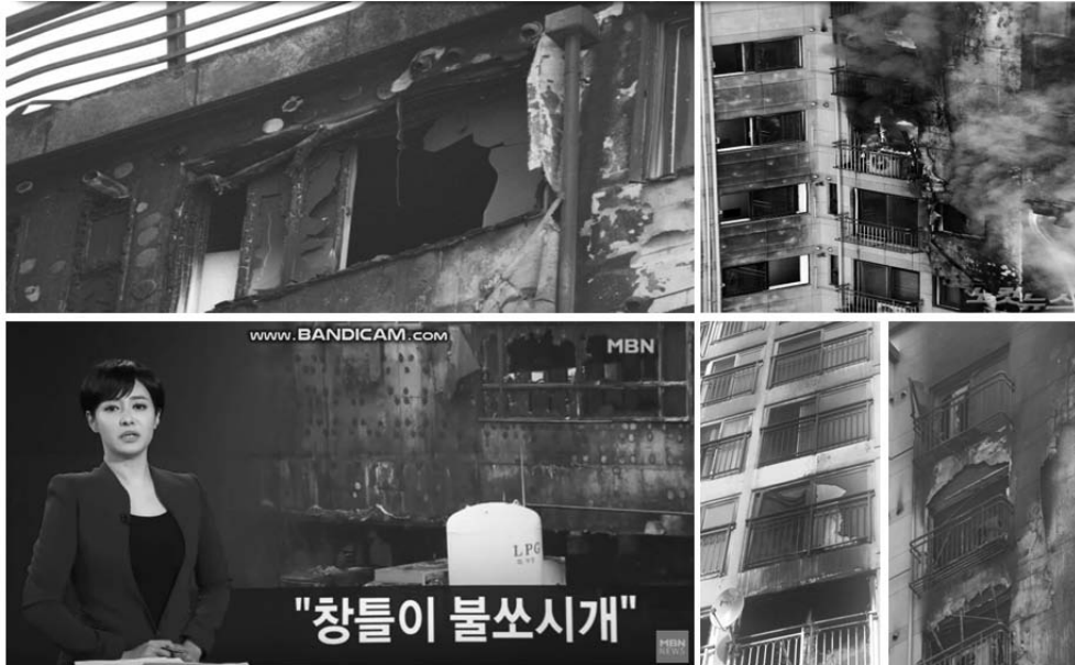
〈그림 4〉 국내외 고층 건축물 화재사례(개구부를 통한 상층부로의 연소확대)
