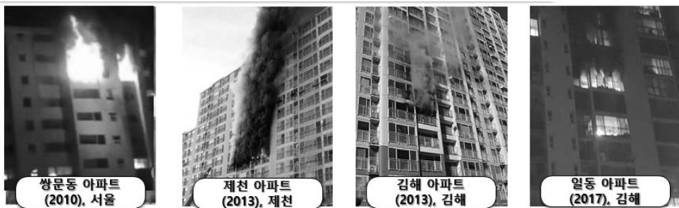
<그림 3> 국내외 고층 건축물 화재사례(개구부를 통한 상층부로의 연소확대)
