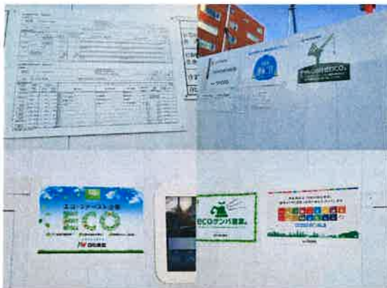
삿포로시 실제 설계 지원 받고 S등급 받은 건물 시공 현장
