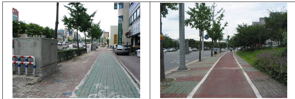
[그림 3-25] 승차감이 낮은 재질로 시공한 자전거도로
