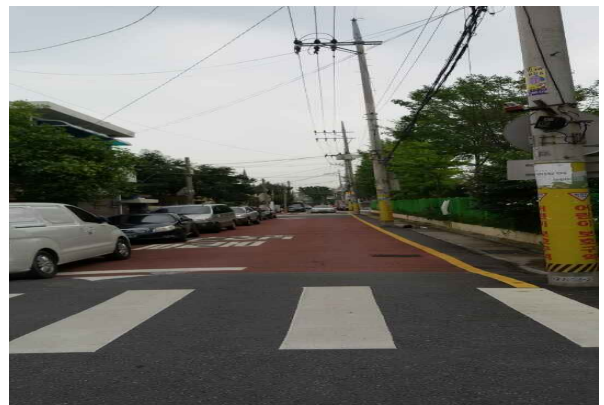
모니터링 장소 : 문화초등학교 정문앞 사진 설명 : 보행자를 위한 안전범위 지정 및 정지선과 횡단보도 어린이 보호구역표시는 양호하나 불법 주차차량이 많음
