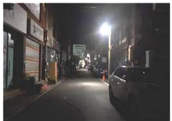
모니터링 장소 : 연합정형외과 병원부근 사진 설명 : 가로등의 밝기는 개선되었으나, 간격이 넓고 높음.
