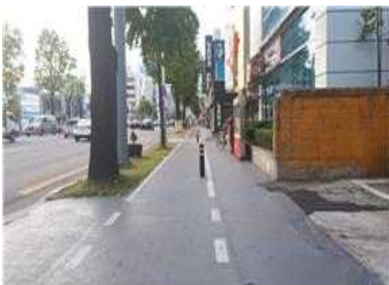
모니터링 장소 : 용문동 우체국 앞 사진 설명 : 자전거 도로에 블라드가 설치되어 있어 자칫 안전 사고의 우려가 있음
