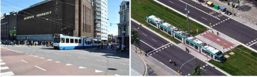
트램·자동차 겸용 도로의 노면표지와 부분적 노면 녹화로 친환경적인 가로환경 조성 사례_암스테르담
