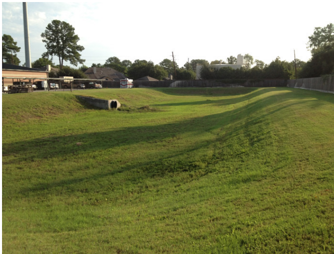
[그림 4-13] Dry Extended Pond 사례
