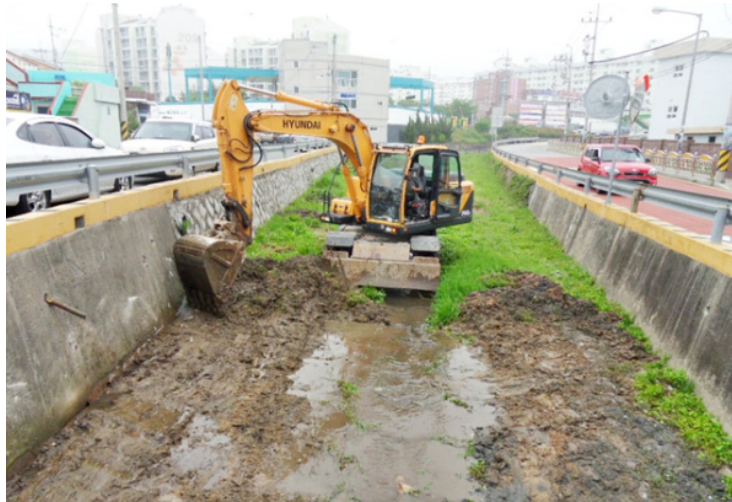
[그림 4-10] 하천의 퇴적토 및 비점오염원을 저감하기 위한 하상 준설
