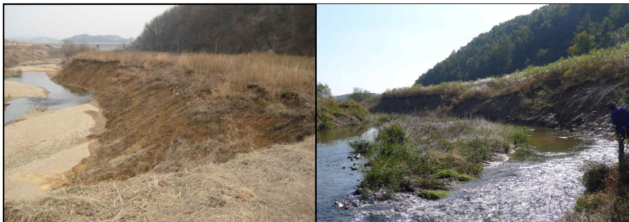
왼쪽) 2013년 역행침식 현장, 오른쪽) 2014년 같은 지역의 역행침식 진행현황 자료 : 충청남도(2015), 금강정비사업 이후 수환경모니터링 4차년도
