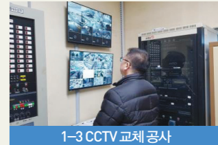
1-3 CCTV 교체 공사
