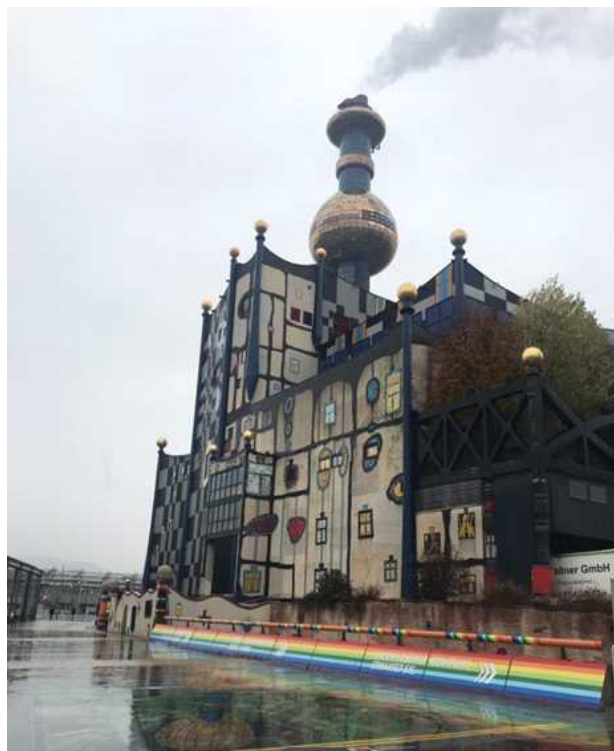
〈 슈퍼텔라우 쓰레기 소각장 전경 〉
