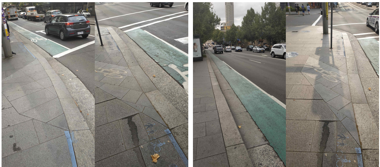
(그림 37) 자전거 통행을 위한 도로 연석 설계
