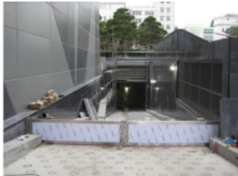
[그림 3-43] 침수방지 차단막 설치
