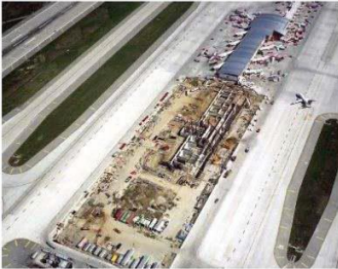
[그림 3-3] 미국 Detroit Metro Airport 쿨 페이브먼트 조성
