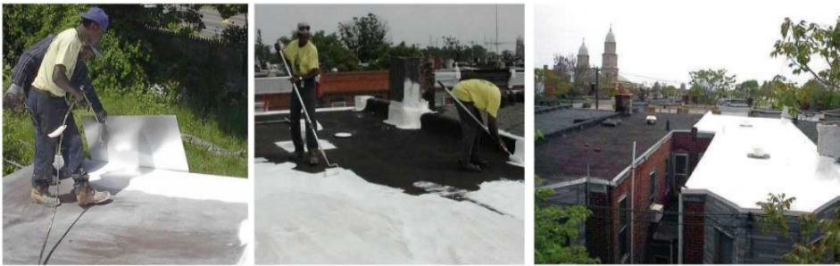
[그림 3-5] 미국 필라델피아 내 쿨 루프(Cool Roof) 조성
