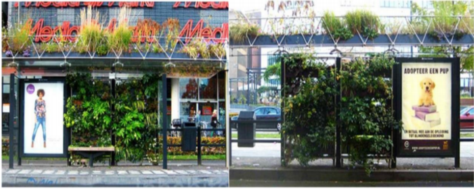
[그림 3-22] 네덜란드 버스정류장 상부 및 벽면 녹화
