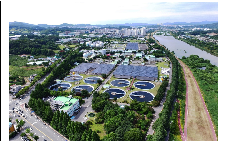
[그림 4-1] 대전하수처리장 전경
