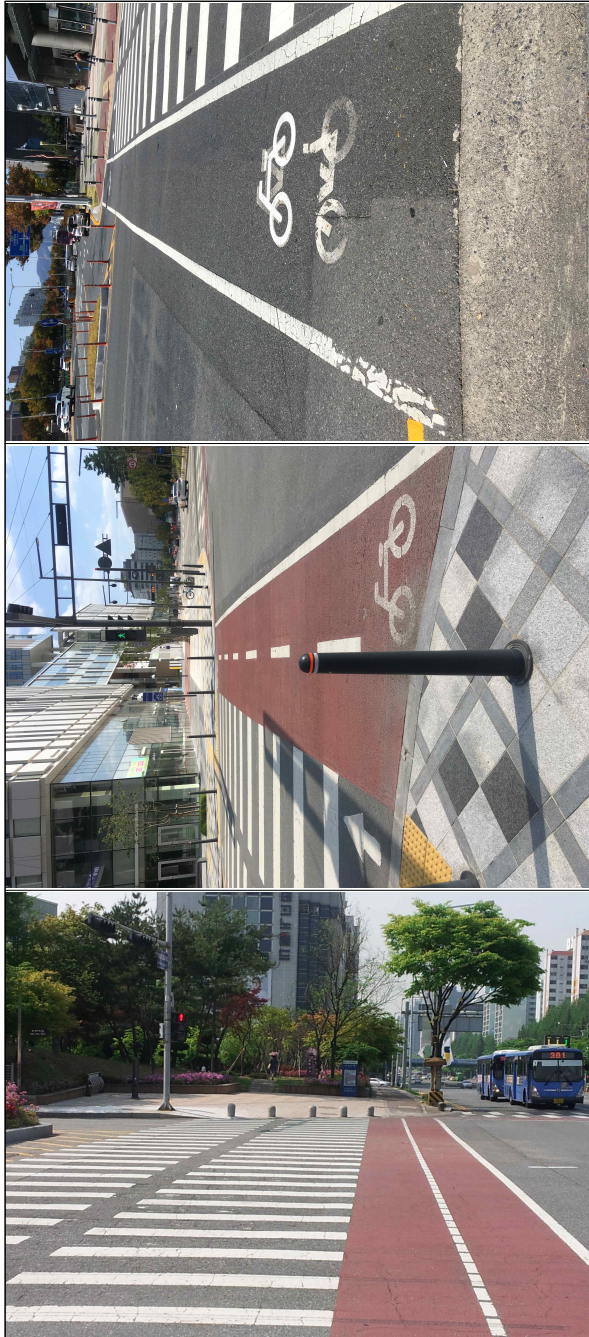
[그림 3-17] 제각각 설치된 자전거횡단도
