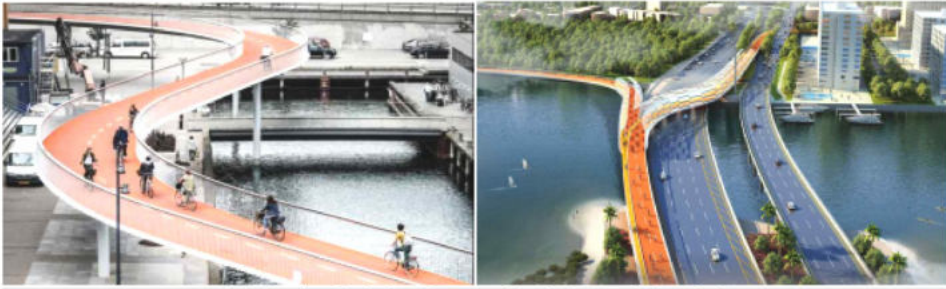
(덴마크) 자전거 전용 고가 연결로 설치 사례
