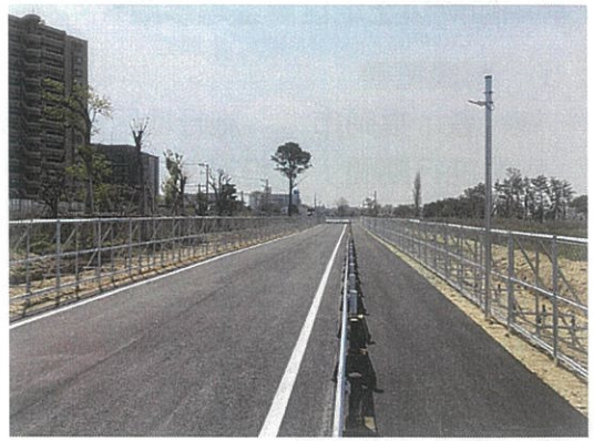
③ 仮設道路
