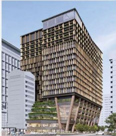
⑦天神1-7計画 オフィス・ホテル・商業 ※外装にCLT(※3)パネルを利用
