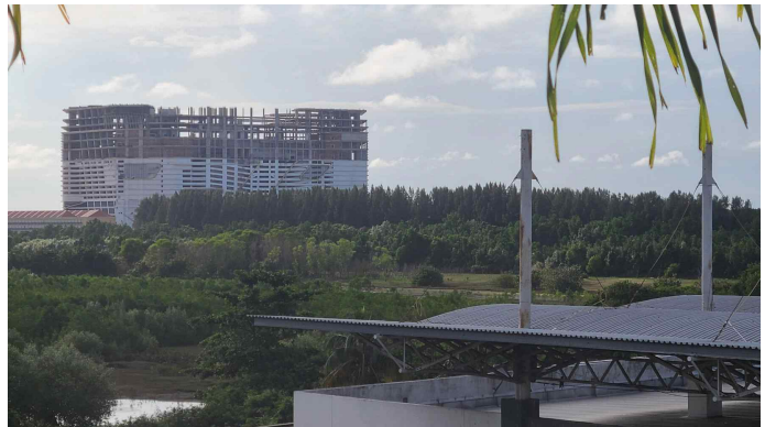
[그림 기 건설 중인 건물 모습
