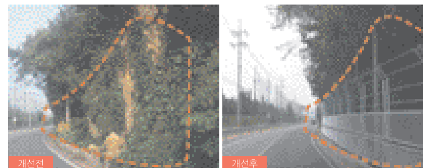
도로변 절개지 낙석지역 방호벽 설치사례
