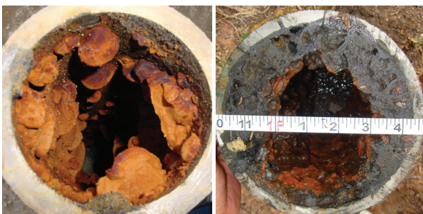
〈그림3. 스케일 및 녹에 의한 통수면적의 감소〉
