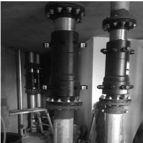
(c) 입상배관의 멀티조인트 활용 내진 시공
