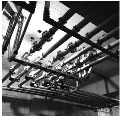
(d) 수평배관의 볼조인트 활용 내진 시공
