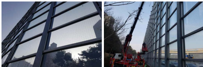
그림 1. 대전시 반석 방음벽의 저감테이프 부착 전경
